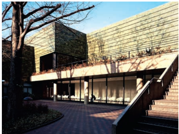
中庭から見た新館(改修前)
