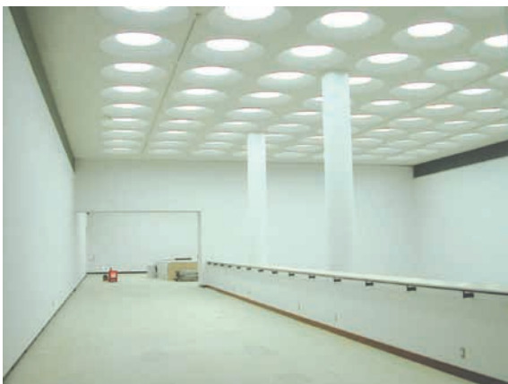
改修中の新館展示室
