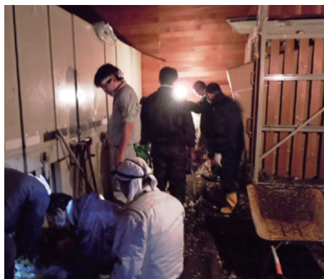
美術収蔵庫内の土砂撤去（石巻文化センター）
