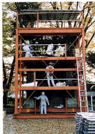
地獄の門の表側をスポンジとウレタンで養生を始めたところ
